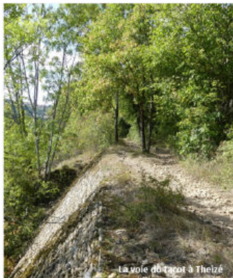
La voie du tacot à Theizé
