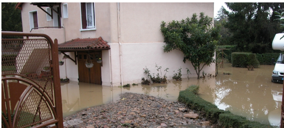
Figure n°6 : Crue de 2008 habitation sur l'avenue de la Gare
